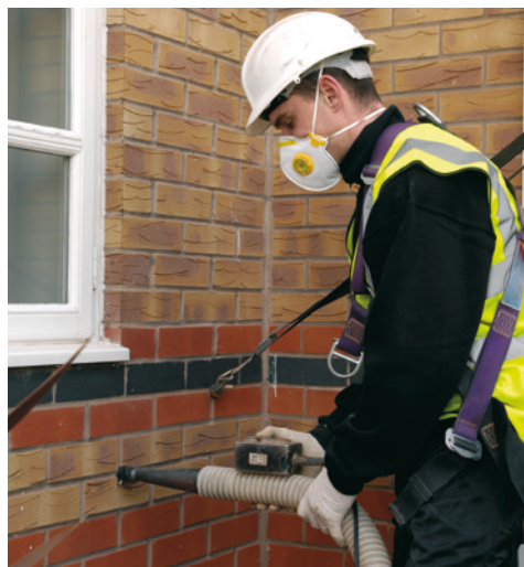
3 Proceso de insuflado.
