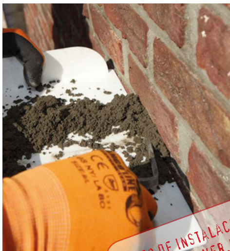
4 Sellado de agujeros y acabados.
