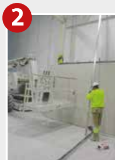
2 Instalación de estructura Instalação de estrutura
