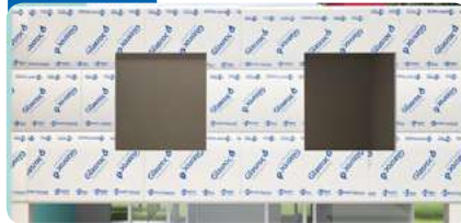
Colocación placa exterior Glasroc® X / Aquaroc®.
