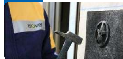
Colocación de aislamiento
