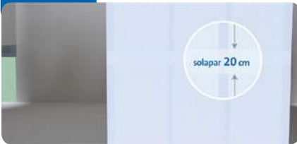
Colocación lámina impermeable.
