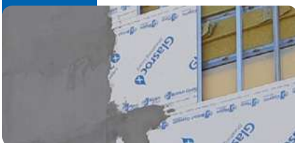
Aplicación capa de regularización
