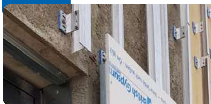
Instalación de la placa
