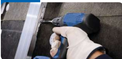
Colocación de perfiles T y L
