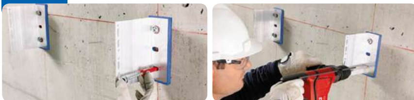
Colocación de ménsulas de sujeción y retención
