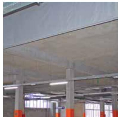
**PERLIWOOL®** es un nuevo concepto en morteros proyectados en base seca, compuesto de lana mineral y perlita con cemento como único ligante hidráulico, utilizado principalmente para la protección contra incendios de elementos constructivos.
