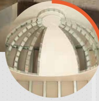
Para la conexión entre pared y techo, es suficiente insertar los Montantes Flexibles CONCAV & CONVEX en el Canal Flexible COBRA 30mm, doblado según el ángulo adecuado.
