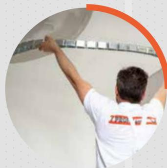
Se pueden **torcer fácilmente** a mano en toda dirección. Una vez doblados en la sección deseada, **mantienen la curvatura** sin necesitar otros sistemas de refuerzo.
