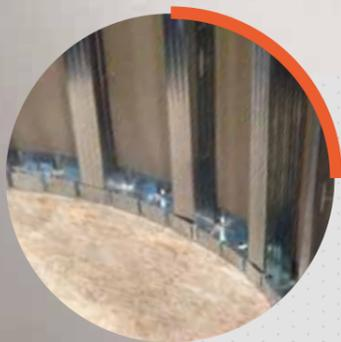
Los montantes C deslizan muy fácilmente en el Canal Flexible COBRA durante la creación de una pared curva y, una vez puestos en la posición deseada, **quedan automáticamente bloqueados** y perfectamente perpendiculares.
