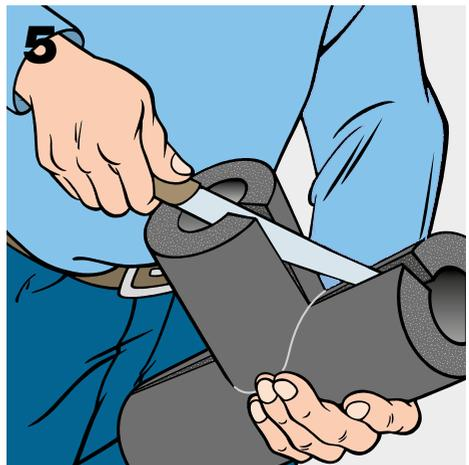
Colocar la pieza que hemos realizado sobre el ramal a aislar.
