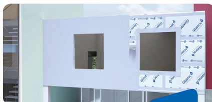
APLICACIÓN DE MORTERO PARA CAPA DE REGULARIZACIÓN
