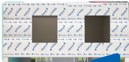
COLOCACIÓN PLACA EXTERIOR GLASROC® X / AQUAROC®
